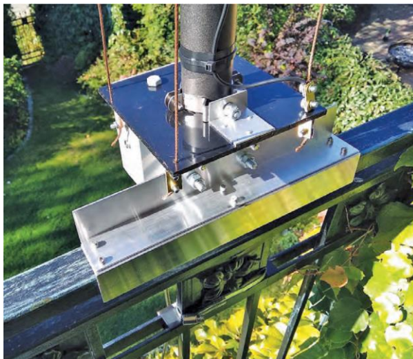
Fot. 6.6.2. Szczegóły montażu podstawy anteny i umocowania przewodów strojnika
